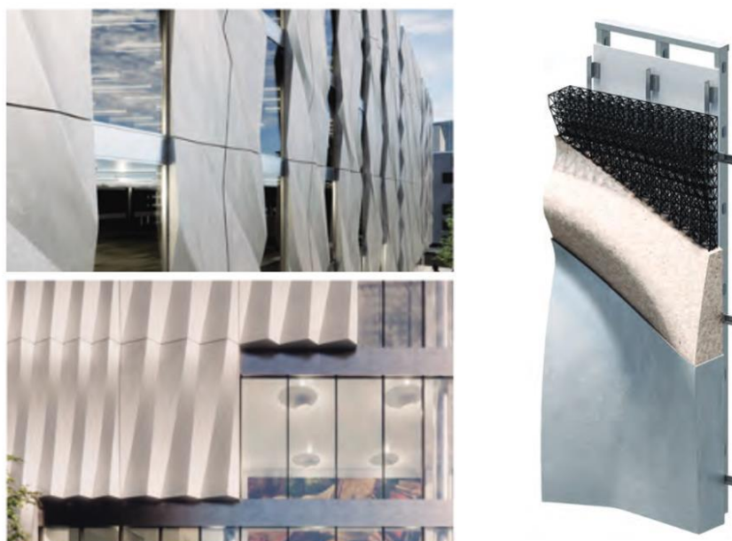
Obr. 2-18 Architektonické aplikace 3D tištěných prutových struktur – fasádní panely a cellular matrice [40]
